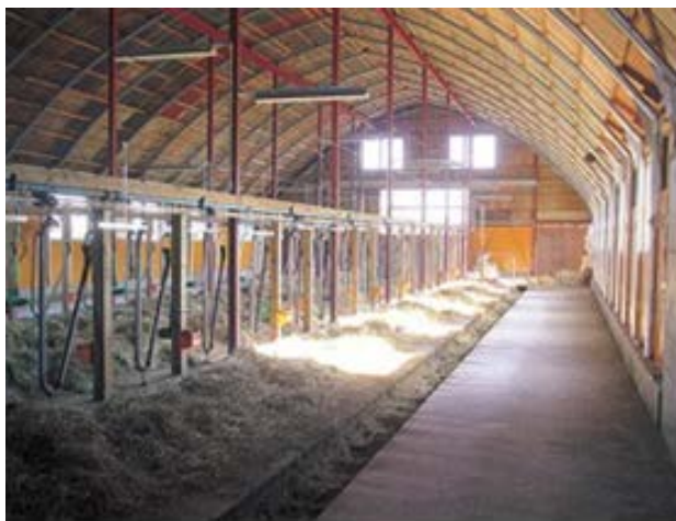
改修して天井が高くなった森高牧場の牛舎
